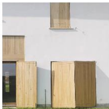
Enduit Volets bois mélèze enduit d'imprégnation serrurerie Métallique
