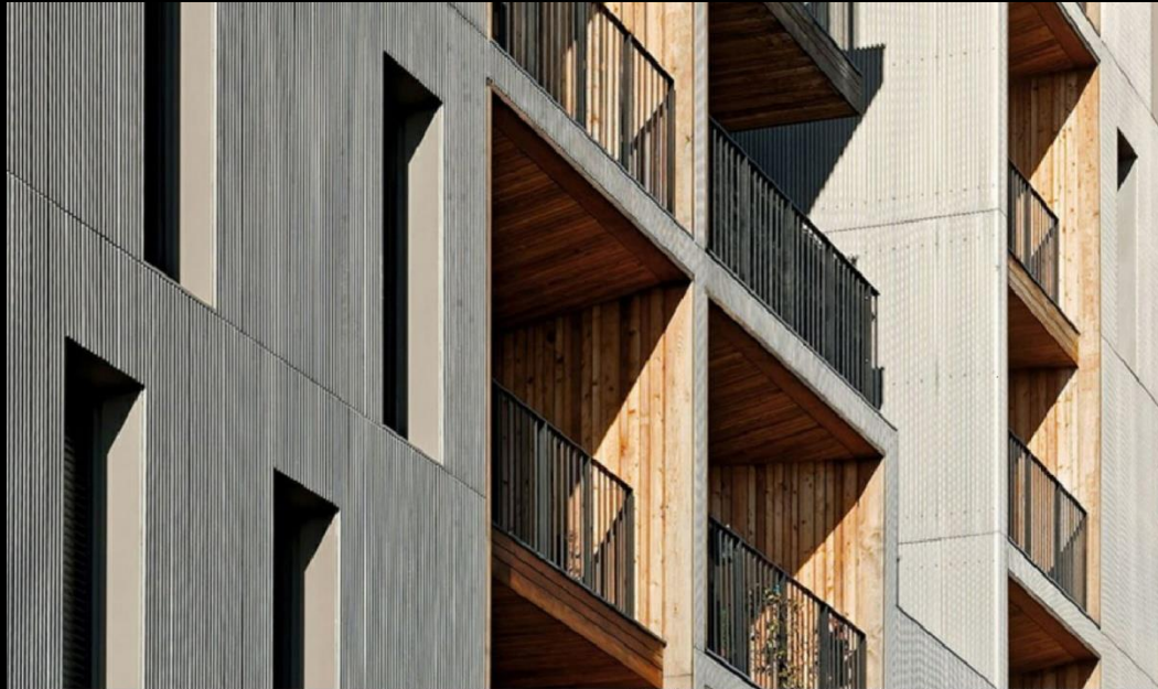
Bardage métallique thermolaqué et fonds de loggias en bois, Leibar Seigneurin architectes
