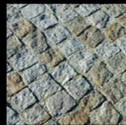
Pavés de réemploi joints maçonnés ou sablés ou végétalisés
