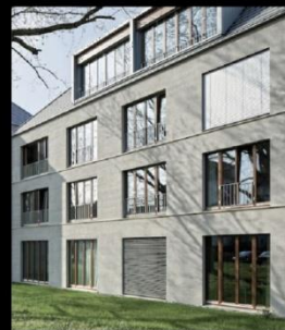
Menuiseries bois, béton apparent, garde-corps en métallerie Wannenmacher Möller architectes
