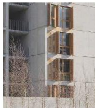
béton lauré allèges vitrées persiennes mélèze
