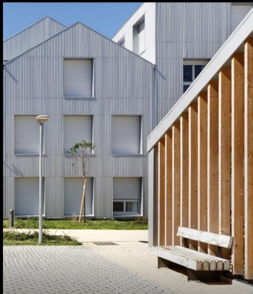
Bardage métallique et RdC bois SOA architectes
