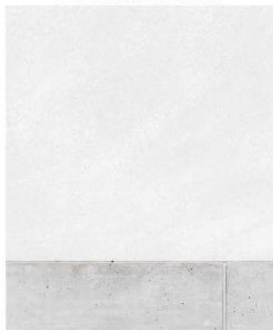
Enduit chaux Soubassement béton
