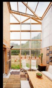
Auvent en polycarbonate sur charpente bois Detroit architecte
