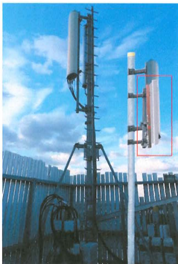
Vue de la terrasse S2 après travaux
