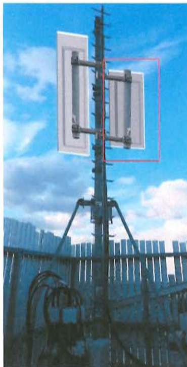
Vue de la terrasse S1 après travaux
