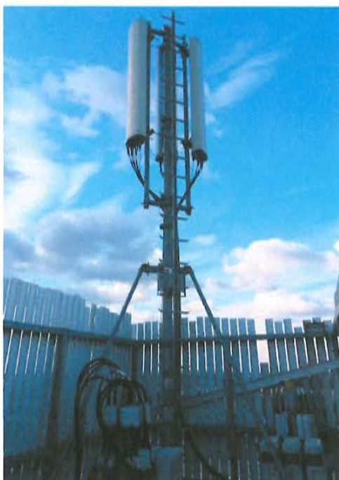
Vue de la terrasse S0 avant travaux
