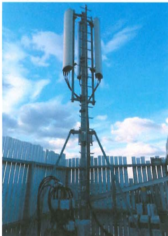
Vue de la terrasse S1 avant travaux
