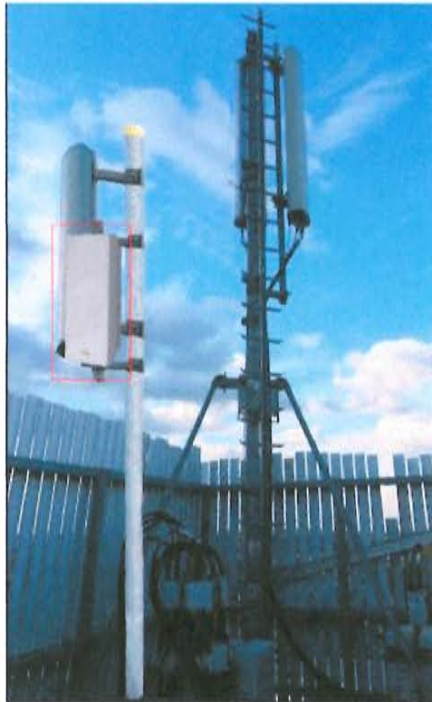
Vue de la terrasse S0 après travaux
