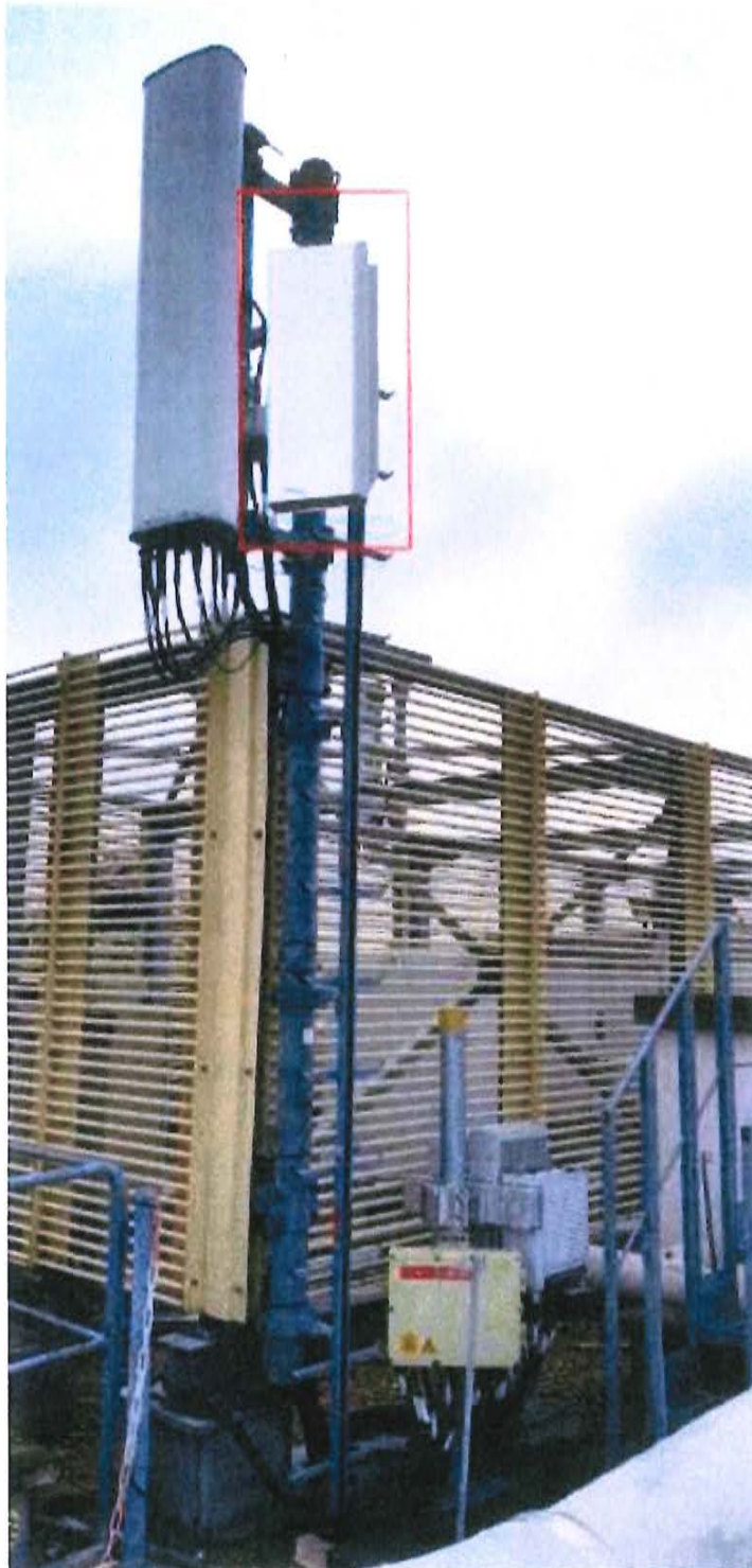
Vue de la terrasse S0 après travaux
