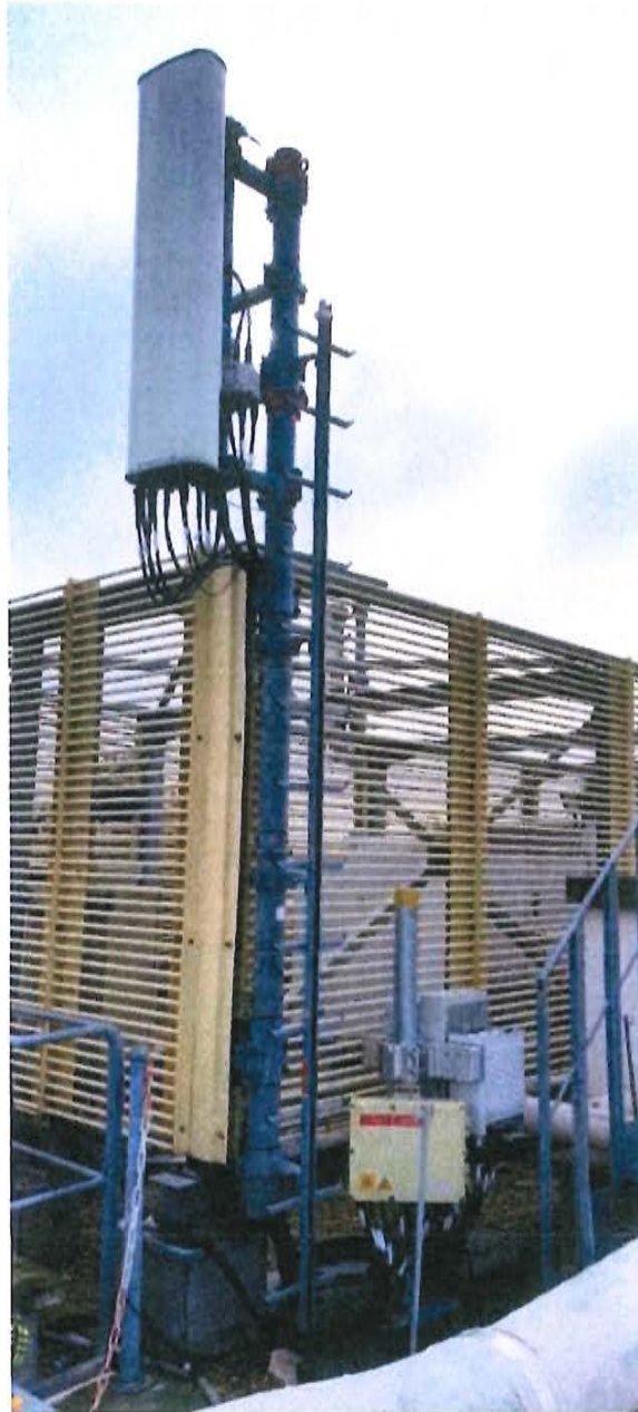
Vue de la terrasse S0 Avant travaux
