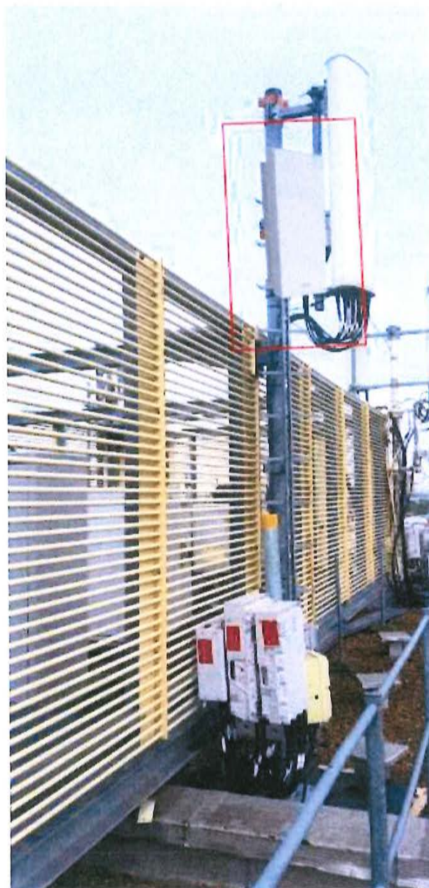
Vue de la terrasse S1 après travaux
