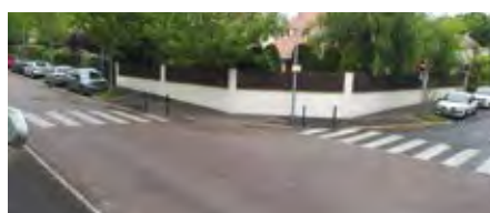
Aménagement du carrefour entre la voie au Lard et la rue de la Grange 61 voix
