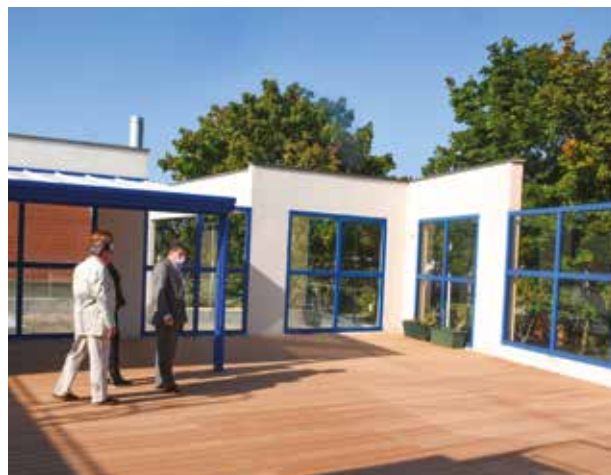
Durant l'été, les Services de la Ville ont réaménagé la terrasse de l'école de la Grange en rajoutant un préau couvert. Un espace de jeu supplémentaire quelle que soit la météo.
